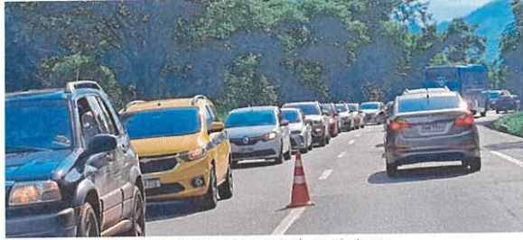
Obras terão investimento da CCR RioSP de R$ 1,2 bilhão e vão desafogar o trânsito na via.
